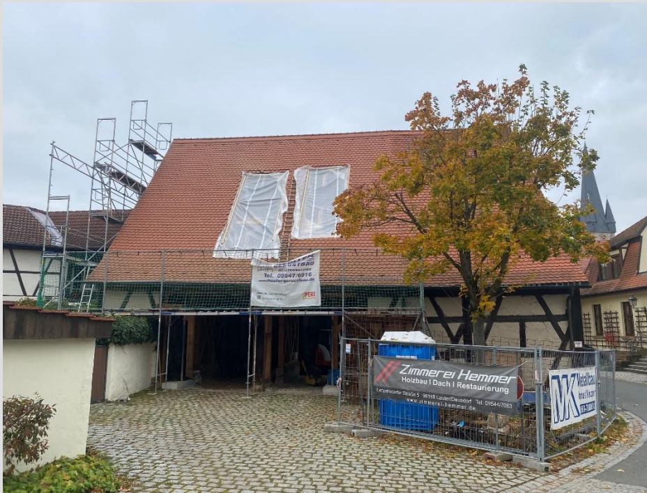
Zehntscheune / Hölzerne Männer Fertigstellung im Frühjahr 2022, Arbeiten laufen aktuell
